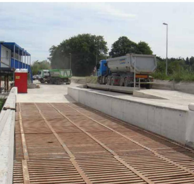
Im Vordergrund die Abrollstrecke für die Lastwagen durch das «Waschbecken». Der Rost ist im Betrieb ca. 15 bis 20 cm unter Wasser. Bei der Durchfahrt werden die Räder der Lastwagen abgespült. Rechts im Bild die Lastwagenwaage, auf der die ankommenden und die ausfahrenden Lastwagen gewogen, kontrolliert und dokumentiert werden. Links das Kontroll- und Erfassungszentrum.
