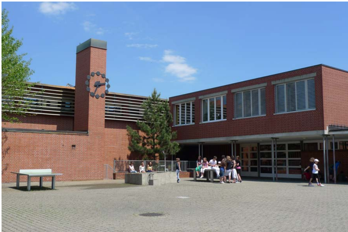
Die Schulanlage "Ländli"; hier das Schulhaus "Ländli" 1 mit der Alten Turnhalle.
