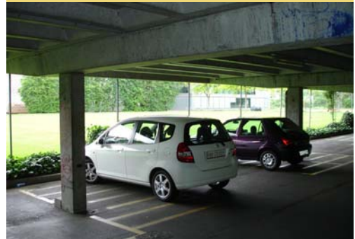
Natürlich belichtete Parkierungsanlage
