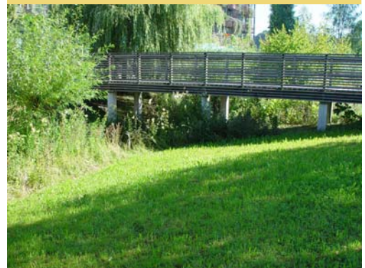
Beispiel eines Bachüberganges
