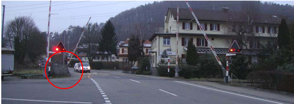
Abbildung 10: Sichtbehinderung durch Prellbock
