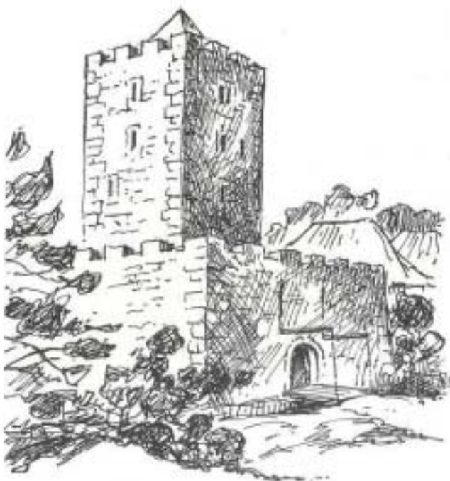
Der 18 Meter hohe Viereckturm bestand aus Lägernkalkbrocken und Bollensteinen.
