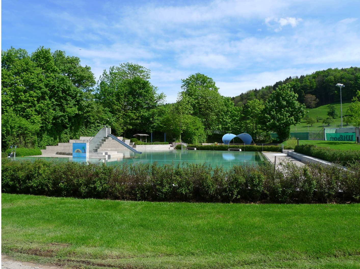
Blick auf das Nichtschwimmerbecken mit Rutschbahn und Betonstufen im Hintergrund
