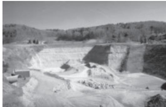
*Die Kiesgrube im Tägerhard zeigt stark wechselnde Schichten von Flussschotter und wenig Moränenablagerungen im tiefsten Bereich.*
