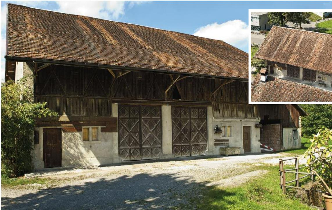
Wichtig ist auch ein trockener, gut nutzbarer Vorplatz an den Längsseiten. Daher ist das Dach weit ausladend, auf der Hauptseite gegen den Furtbach noch mehr als auf der Rückseite. Dies erfordert eine entsprechende Konstruktion mit einer Flugpfette, die von den schrägen Bughölzern und beidseitigen Kopfhölzern abgestützt wird.
