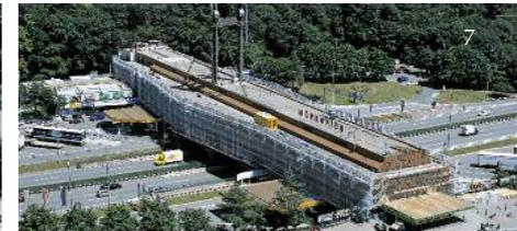
Hubertus Menke aus München hat die neue Farbgestaltung entworfen. Die Fassade wurde nach einer gründlichen Reinigung der Oberfläche zuerst angeschliffen. Danach konnte die neue Farbe aufgetragen werden. Mit der Hilfe eines Rasters
